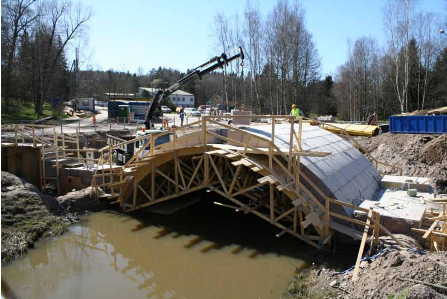
Sillan lakikiven asennus 24.04.2008
