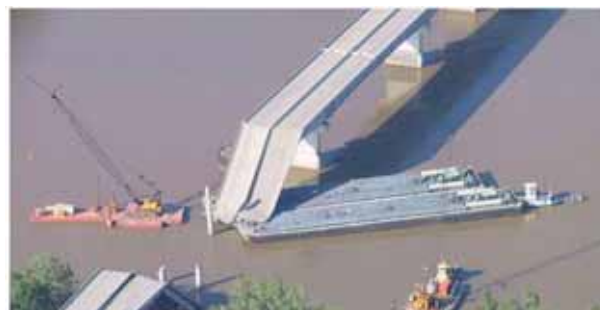
I-40 Bridge, Oklahoma (avattu 1974)
