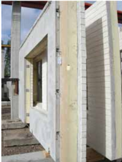
Kuva: Arto Suikka, Rakennusteollisuus RT
