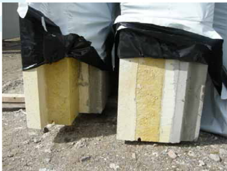
Kuva: Arto Suikka, Rakennusteollisuus RT
